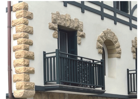
Imagen 28: Detalles en aplacado de piedra sobre SATE. Fuente: Marta Epelde.
