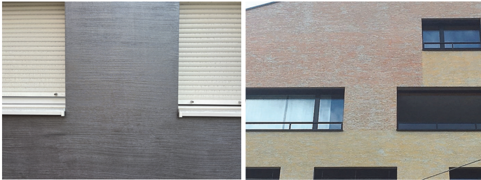
Imagen 25: Ejemplo de textura rayada y brillante en capa de acabado del SATE (Asturias). Fuente: Marta Epelde.
