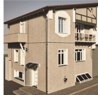
Ilustración 24: Edificio modelo previo al SATE. Fuente: M. Epelde, A. Intxausti.
