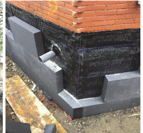
Imagen 9: Pasatubos ejecutado en la envolvente térmica con una membrana líquida aplicada para su tratamiento hermético antes de la instalación del aislamiento. Fuente: Marta Epelde.
