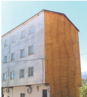
Imagen 11: Fachada existente recubierta de poliuretano. Fuente: Marta Epelde.
