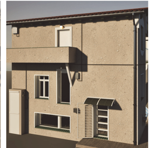
Ilustración 3: Fachada lateral del edificio modelo utilizado en esta publicación. Fuente: M. Epelde, A. Intxausti.
