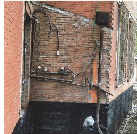
Imagen 8: Instalaciones existentes en fase de retirada y pasatubos en zona de impermeabilización en correcto proceso de ser tratado herméticamente previo a la colocación del aislamiento. Fuente: Marta Epelde.
