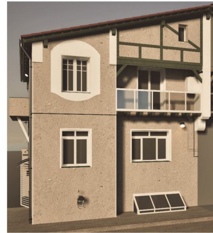
Ilustración 2: Fachada principal del edificio modelo. Fuente: M. Epelde, A. Intxausti.
