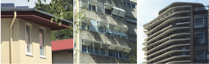
Imagen 14: Sombreamiento fijo horizontal en fachada SATE sur (País Vasco). Fuente: Marta Epelde.
