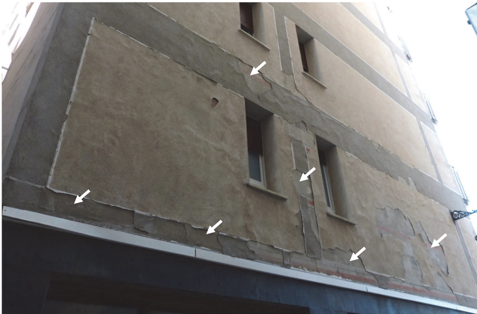
Imagen 34: Patología en las capa reforzada y capa base del aislamiento. Fuente: Marta Epelde.
