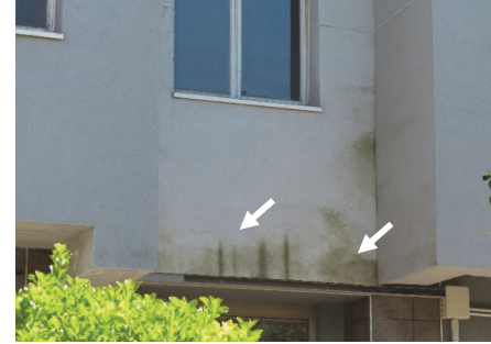
Imagen 41: Contaminación microbiológica en arranque volado del SATE. Fuente: Marta Epelde.
